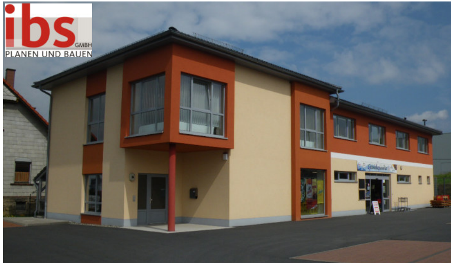
Bauplanungsbüro in Schalkau/ Thüringen
